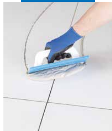
Dreift úr Ultracolor Plus á postulínsgólfplisar með marmaraáferð með gúmmispaða
