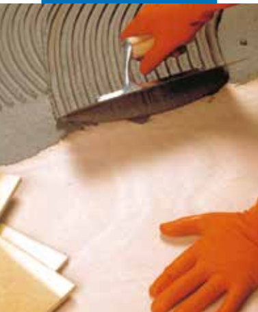
Útlögn postulínsflísa á rakavarinn krossvið með Elastorapid
