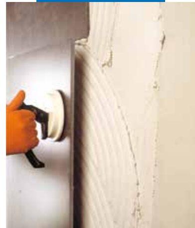
Postulínsflísar lagðar á steinsteyptan vegg með Elastorapid
