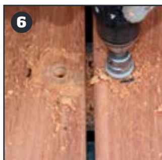
Forboring af huller til propper
