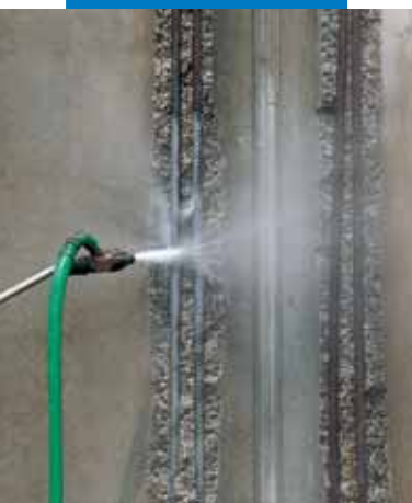
Hreinsun á steypustyrktarjární
